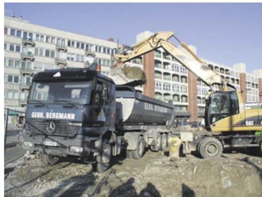
Perfektes Zusammenspiel zwischen Cat-Mobilbagger und Bergmann-Lkw.
